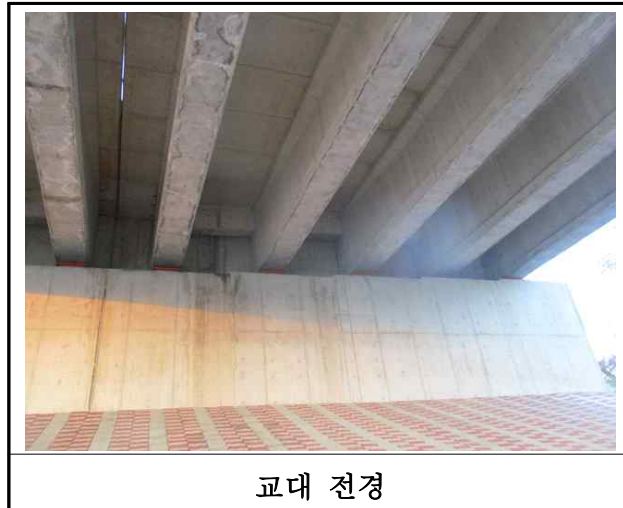
【사진 39.3.6】 교대 전경
