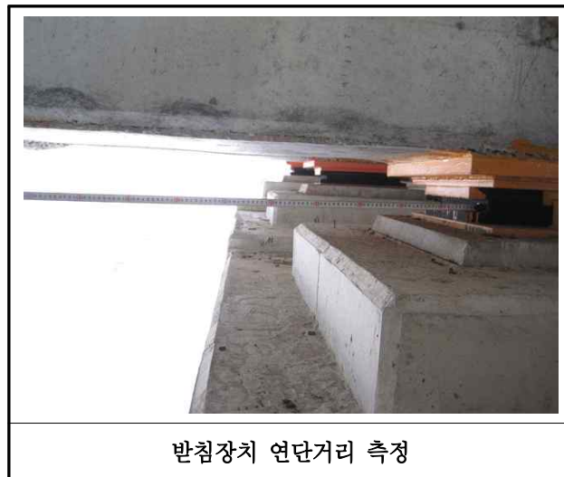
【사진 39.3.30】 교량받침장치 연단거리측정
