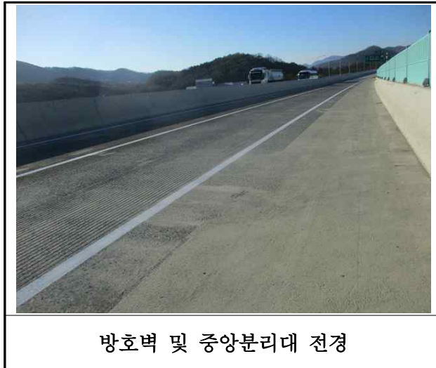
【사진 39.3.39】 방호벽 및 중앙분리대 전경
