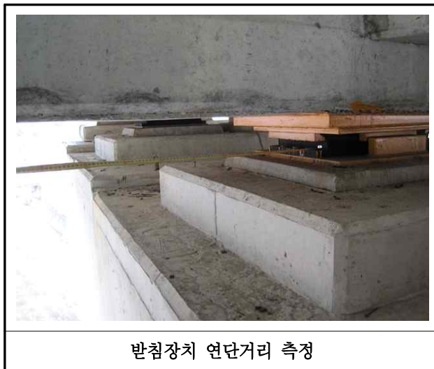
【사진 39.3.12】 교량받침장치 연단거리측정
