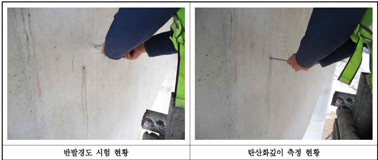
【사진 39.4.1】 콘크리트 내구성조사 현황
