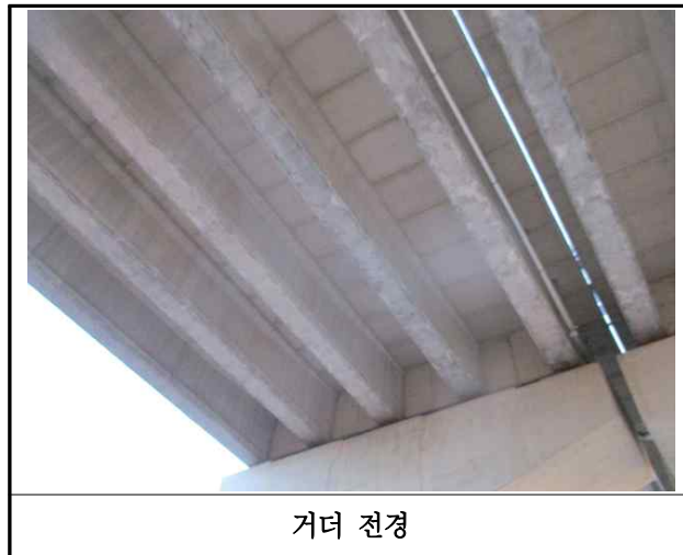
【사진 39.3.3】 거더 전경
