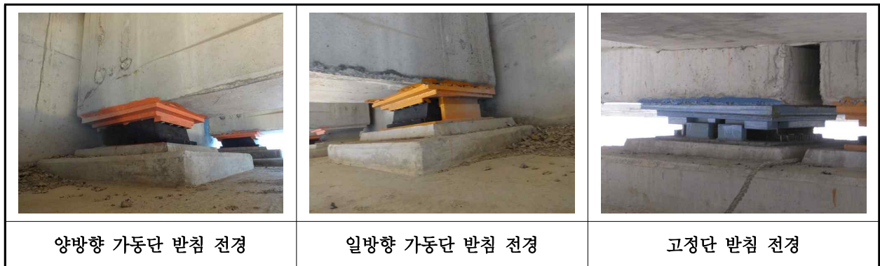
【사진 39.3.10】 교량받침 전경
