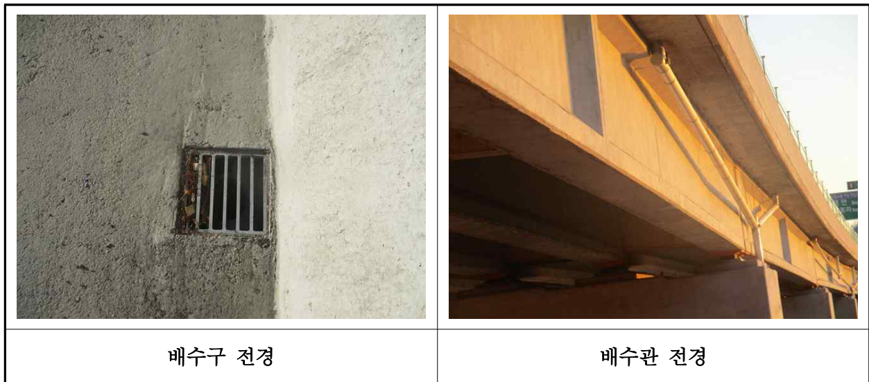
【사진 39.3.37】 배수시설 전경
