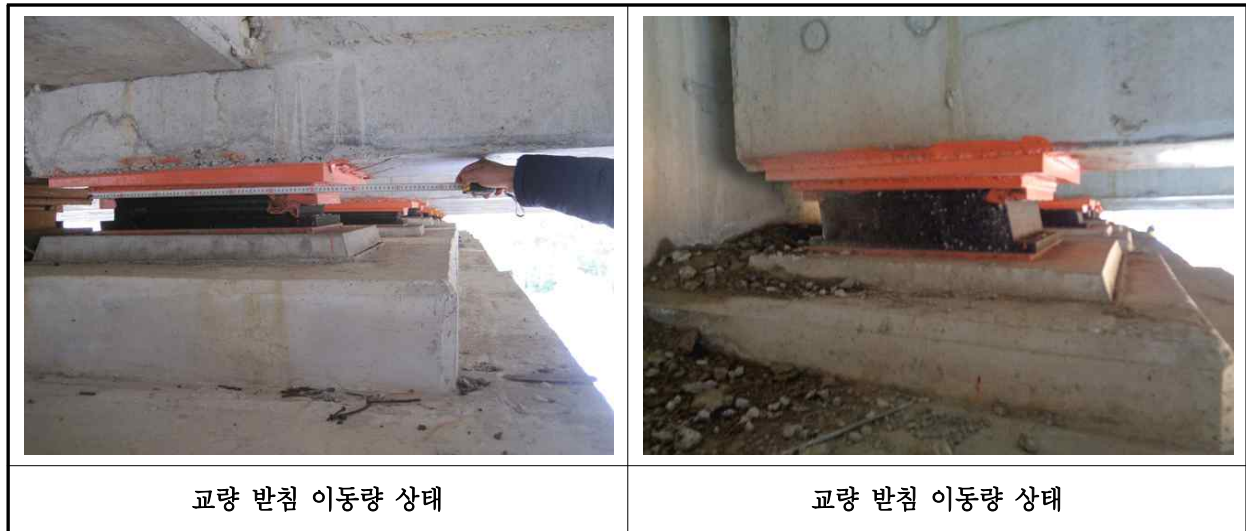
【사진 39.3.13】 교량받침 이동량 상태
