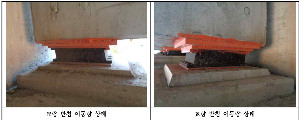
【사진 39.3.31】 교량받침 이동량 상태
