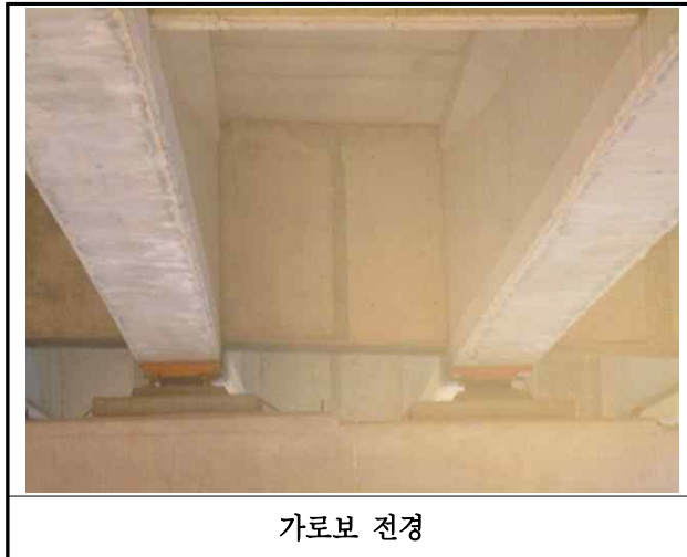
【사진 39.3.24】 가로보 전경
