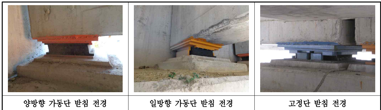
【사진 39.3.28】 교량받침 전경
