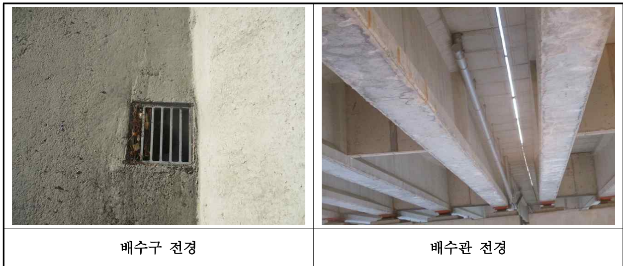
【사진 39.3.19】 배수시설 전경
